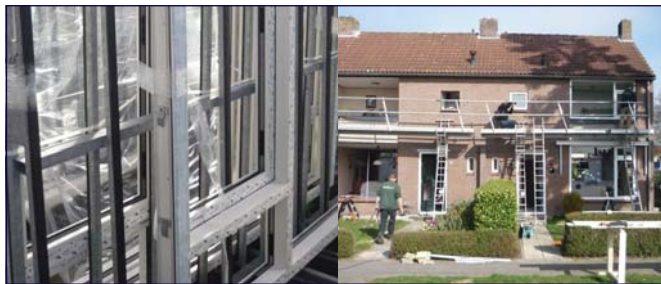
Plaatsen van de nieuwe K-vision Kozijnen
